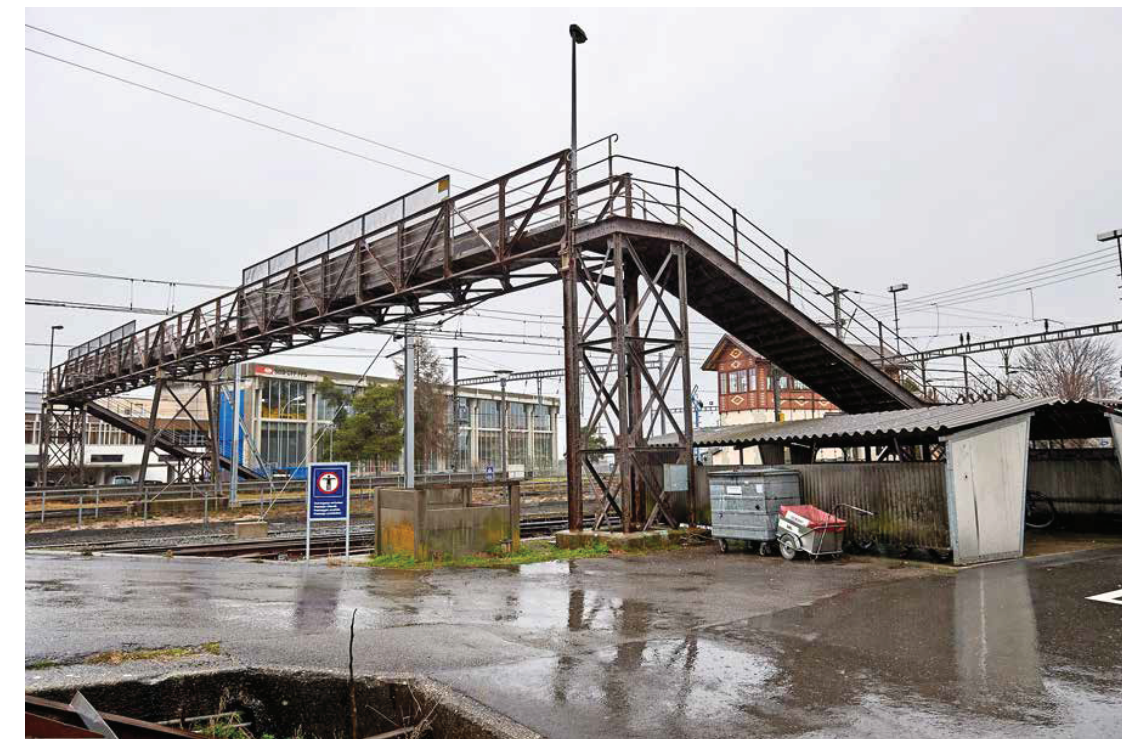
Die Passerelle bildet mit dem Stellwerk (hinter der Treppe) ein historisches Ensemble. Doch die Veloabstellplätze mit Wellblech stören, findet der Verein Passerelle Kerzers.
